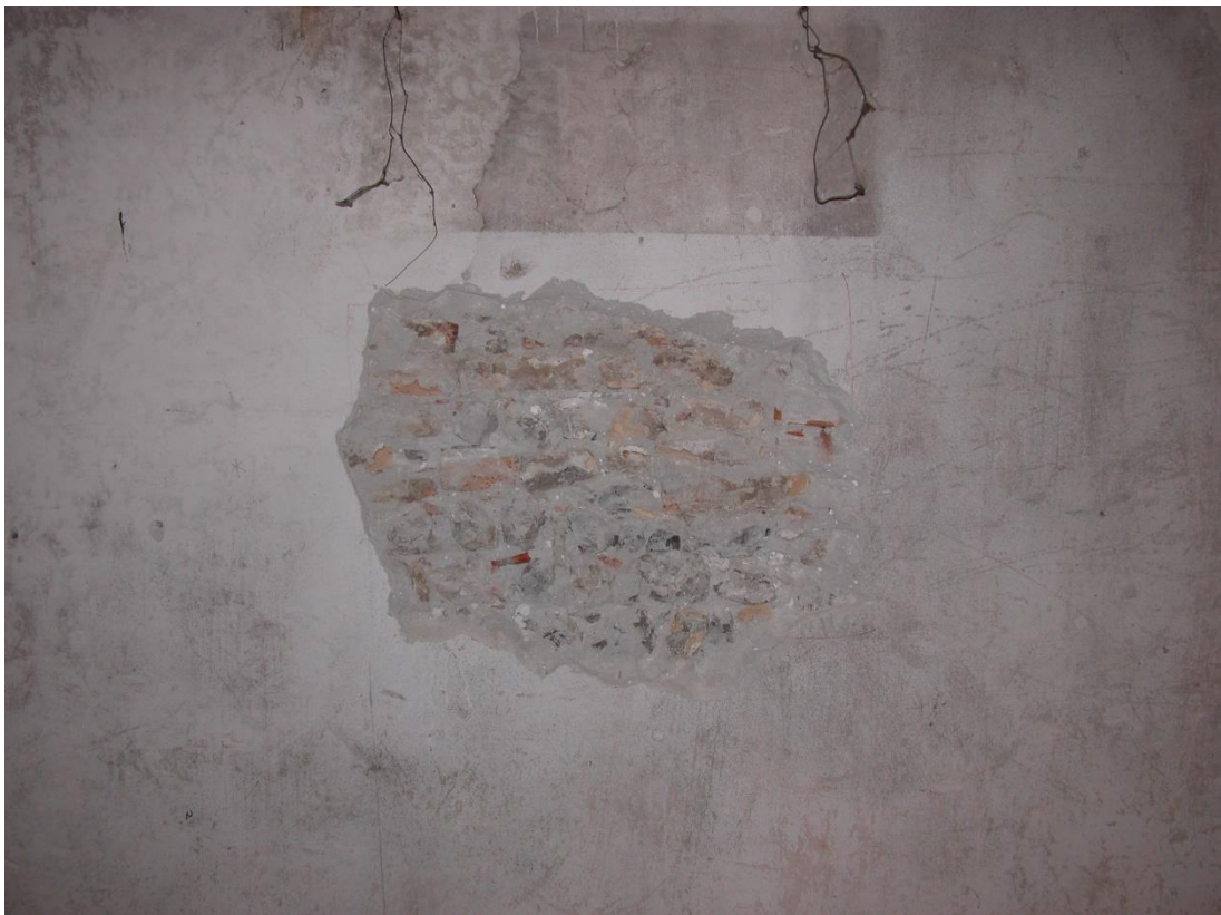
Tipologia della muratura esistente sottotetto corpo "A"
