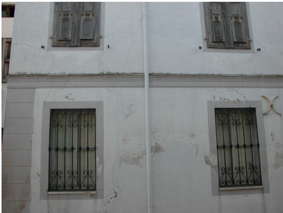
Prospetto strada con ancoraggi tiranti e lesioni lievi nella facciata corpo "A"
