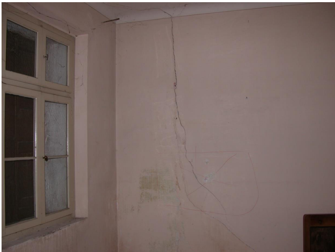
Lesioni in corrispondenza angolo muratura esistente corpo "A"
