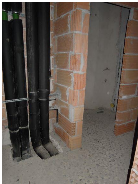
Foto 1 – Montanti dalla centrale termica
